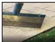
Remplissez les grilles de mortier (Coloré ou pas, au choix). Talocchez la surface à l'aide d'une raclette rigide. La surface des grilles servant facilement de guide.
