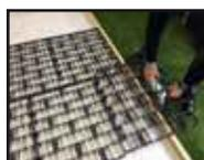
Recouvrez votre surface à réaliser d'un polyane. Posez vos grilles en les emboîtant simplement. Les grilles doivent se poser uniquement en décalé. Prévoyez une pente de 1,5 cm/m pour les eaux pluviales.
