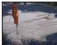
Réalisez vos découpes périphériques à la meuleuse d'angle. Préparez un mortier dans votre bétonnière avec des sacs de mortier "Prêt à l'emploi", ou à la toupie. Prévoyez un hydrofuge de masse dans votre mortier. Prévoyez env. 60 KG / M2 pour le remplissage.
